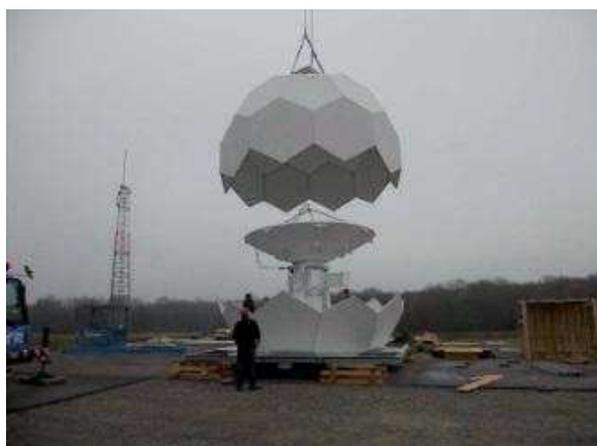
**Abb. 4** Montage des Stealth Radoms und der Antenne in Rauchenwarth im Jahr 2010.
