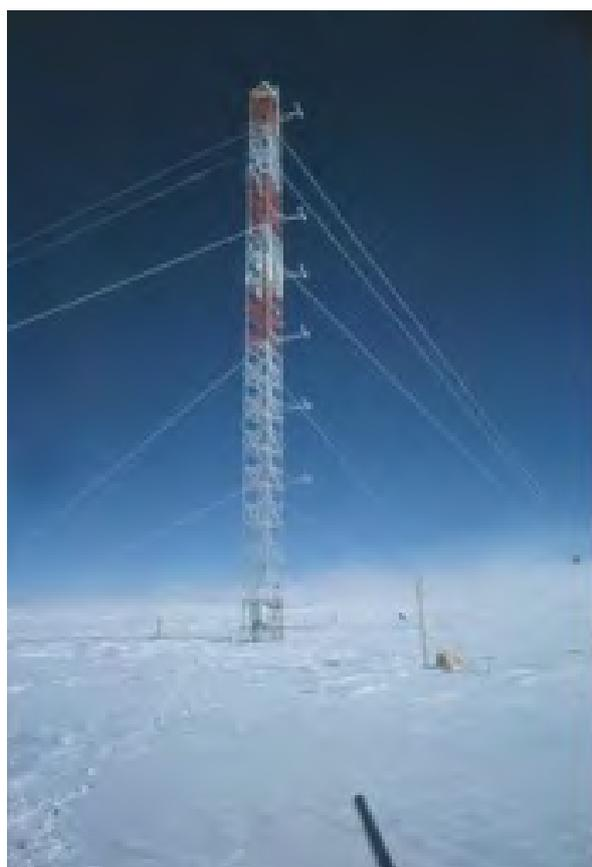
**Abb. 2** Mikrometeorologischer Messturm, Höhe 32 m, bei der Plateau Station in der Antarktis (Bild: Michael Kuhn).
